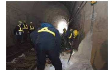
トンネル内の結氷除去作業
