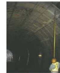
トンネル内のつらら落とし作業
