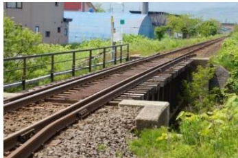
第2登川の橋りょう(1952年完成)
