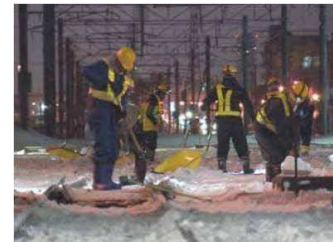
夜間のポイント除雪作業
