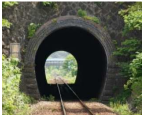
蘭島トンネル(1902年完成)
