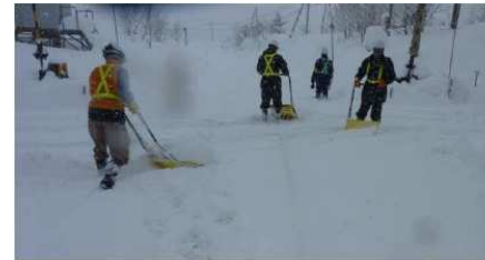
踏切の除雪作業
