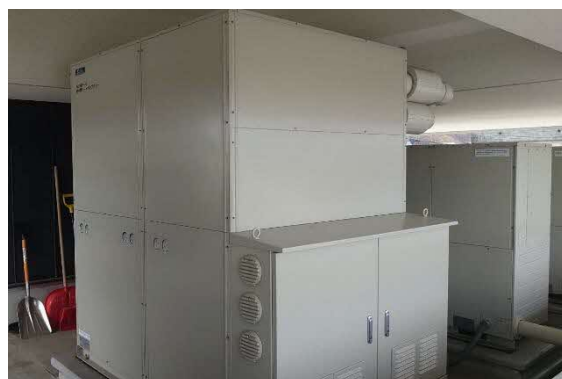
写真 4.2-1 蘭越診療所と導入した地中熱ヒートポンプシステム（ヒートポンプチラー）
