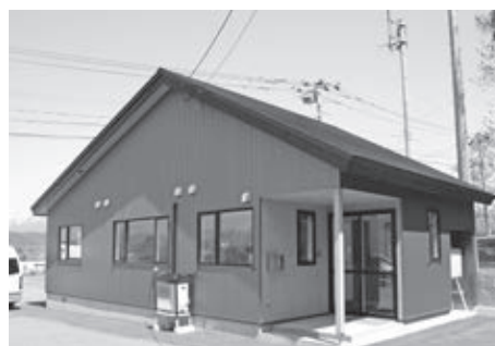
▲ スクールバス車庫事務所新築工事
