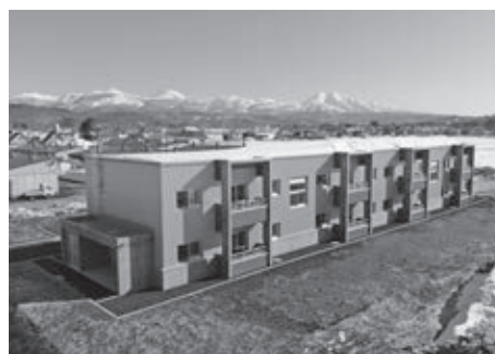
▲ 大谷団地建設工事
