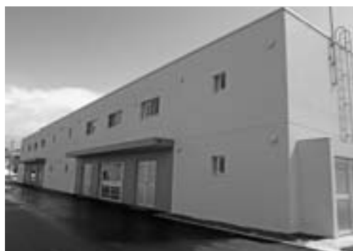
◀ 公営住宅整備事業
